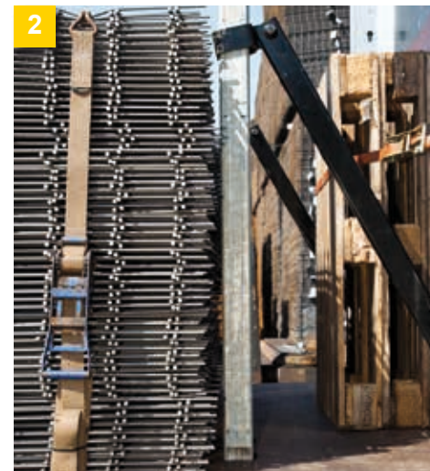
2 Допълнителна опора: Заради голямото натоварване отвесните шпригли са допълнително подпрени в посока напред.
